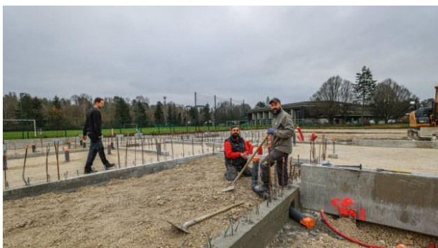
Les premières fondations ont été posées.
